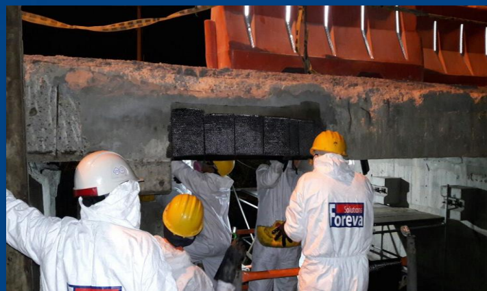
Reparaciones Puente Caño Luisa – Cartagena – Marzo 2017
